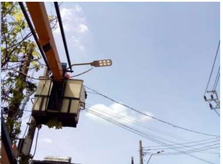
ภาพ การซ่อมแซมไฟฟ้าส่องสว่างบริเวณปากซอย ๓ วัดโมกข์
