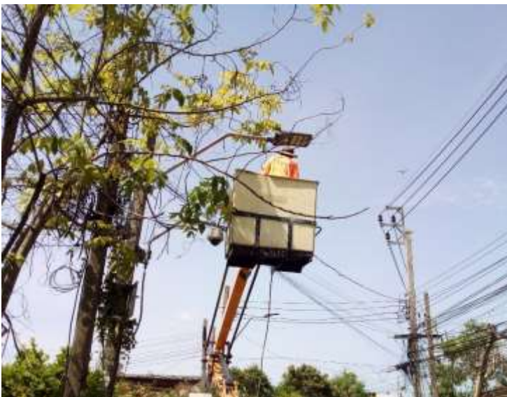
ภาพ การซ่อมแซมไฟฟ้าส่องสว่างบริเวณปากซอย ๓ วัดโมกข์
